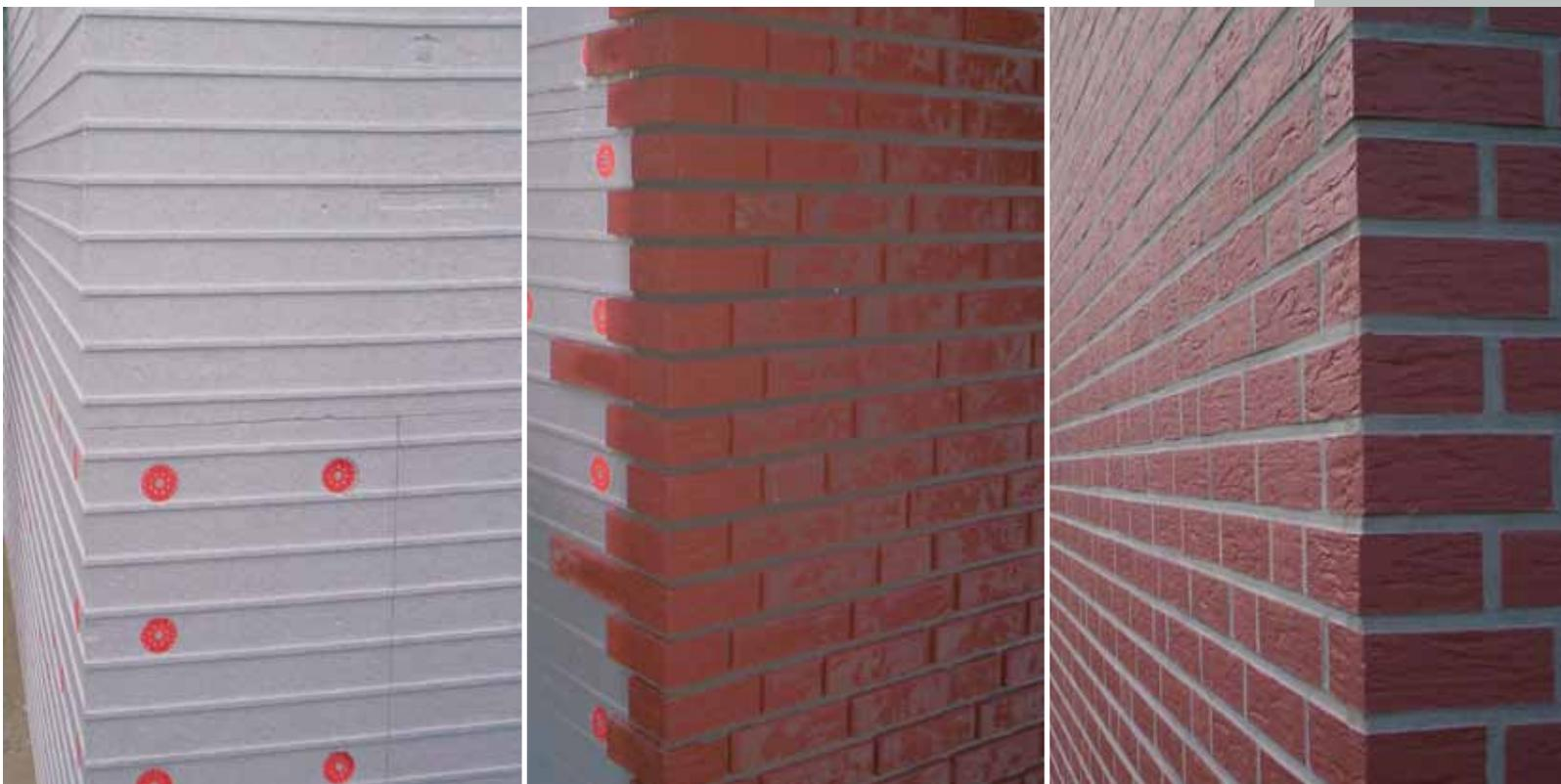
Durch den Einsatz der speziellen Winkelriemchen ist das KamphaTherm System nicht von herkömmlichem Mauerwerk zu unterscheiden.
